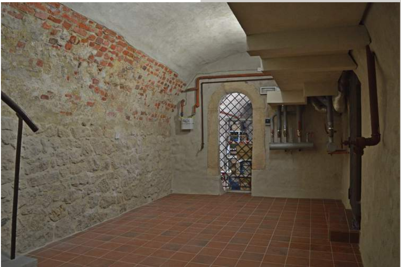
Pomieszczenie piwnicy po remoncie konserwatorskim, fot. Konrad Kołodziejczyk, 2017.
